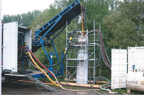
Kanalsanierung mittels Inlinerverfahren, Fuldaabrück
