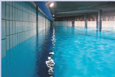
Sanierung Hochbehälter Burgberg, Stadtwerke Baunatal
