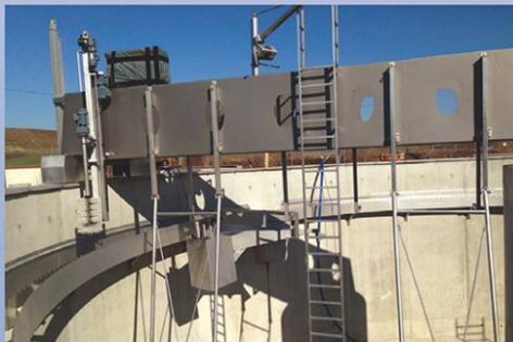
Erweiterung Kläranlage, Calden
