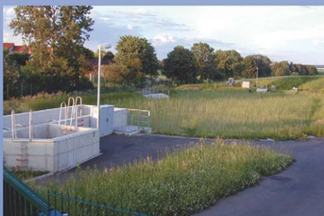
Retentionsbodenfilter Kasselweg, Baunatal
