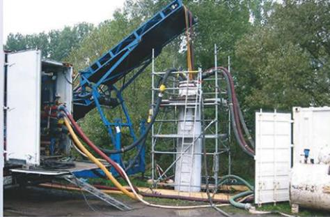
Kanalsanierung mittels Inlinerverfahren, Fuldaabrück
